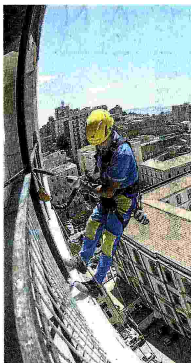
Ristrutturazioni a doppia fune. Intervento su un edificio ad Agrigento
