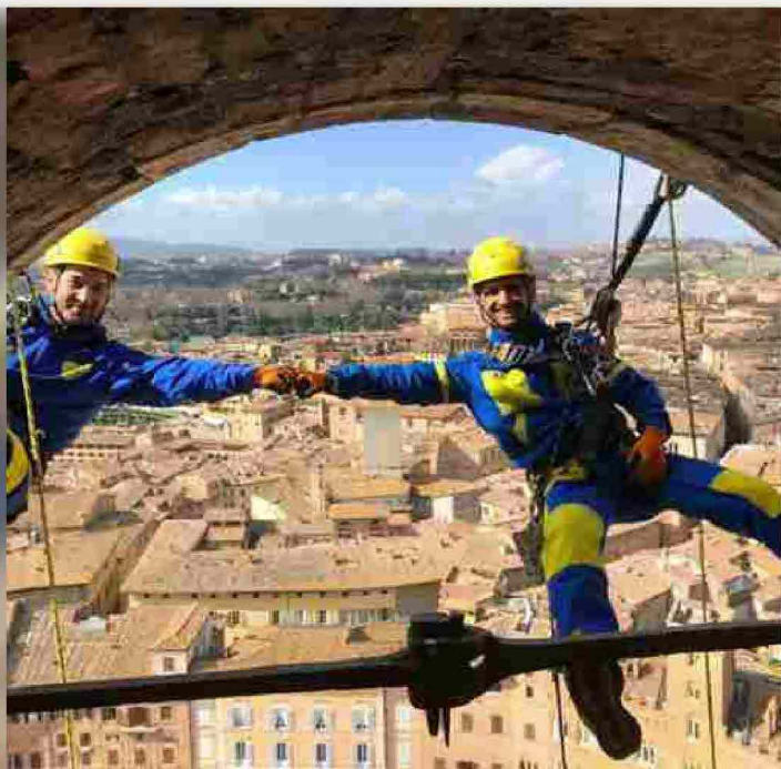
I lavori di Edilizia Acrobatica sulla Torre del Mangia a Siena (foto Paolo Lazzeroni)
